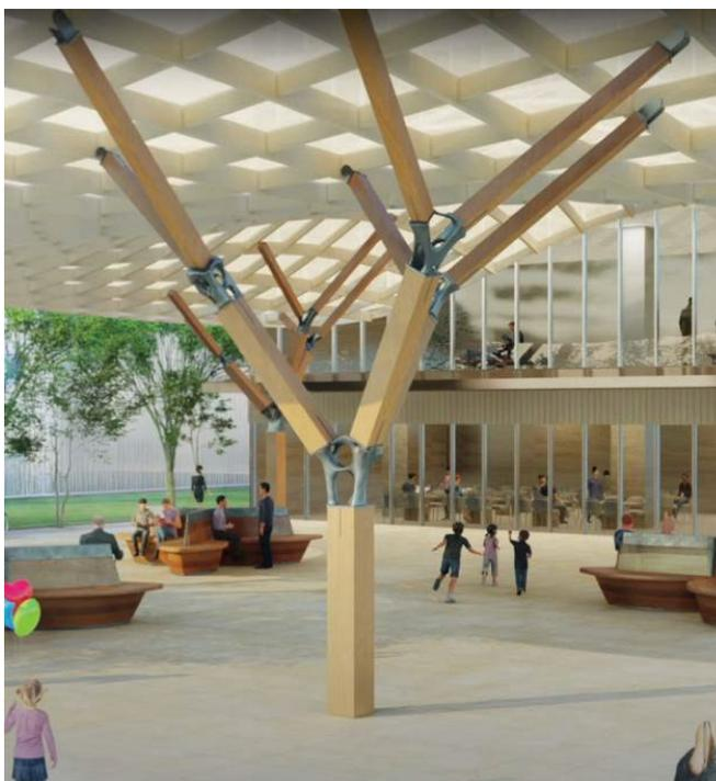
Рис.3. – Общий вид несущих конструкций, собранных с помощью коннекторов Takenaka [28].
