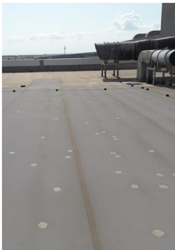
Рисунок – Вид снизу на поврежденный в двух местах градом фрагмент кровельной мембраны с двумя вмятинами и сквозными трещинами (а) и общий вид участка кровли после локального ремонта (б)
