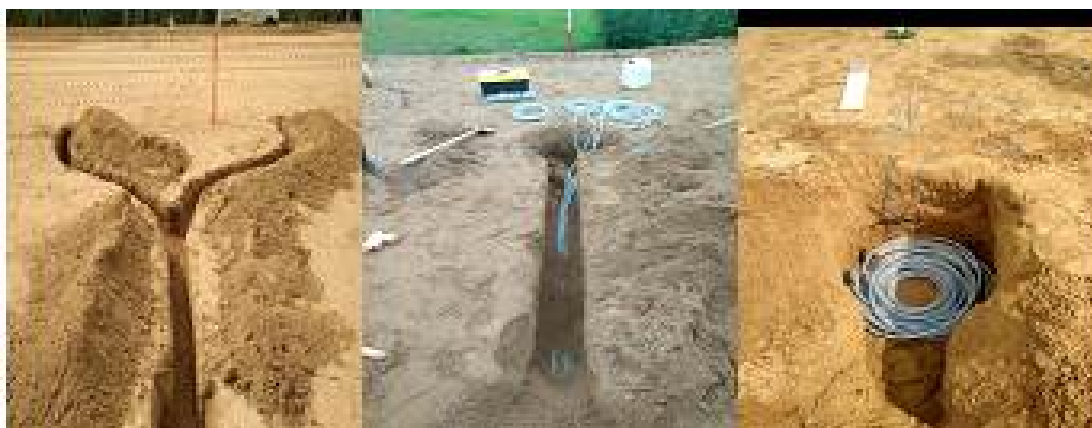
Рис. 7 – Установка датчиков в проектное положение
