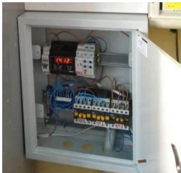
Рис. 5. Фото щита управления режимами работы котлов
