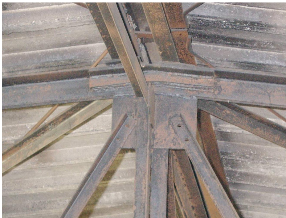
Рис. 2. Фото конькового узла фонаря
