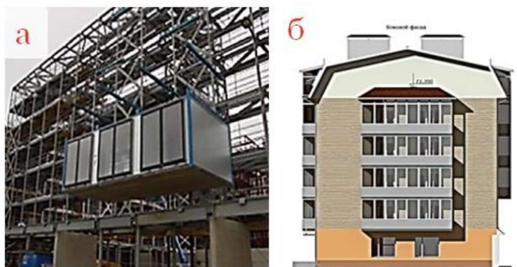
Рис. 1. – Внешний вид объемных модульных блоков для надстройки этажей: а – объемными блок-модулями с опорой на раму зданий с каркасной схемой [7]; б – на базе конструктивной системы СТИЛТАУН [8]
