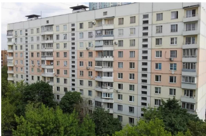
Рис. 1. – Фотография многоквартирного жилого дома серии I-57-A/12 Выбранный объект 1973 года постройки типового проекта серии I-57-A/12 расположен Юго-Западном административном округе г. Москва. Здание
