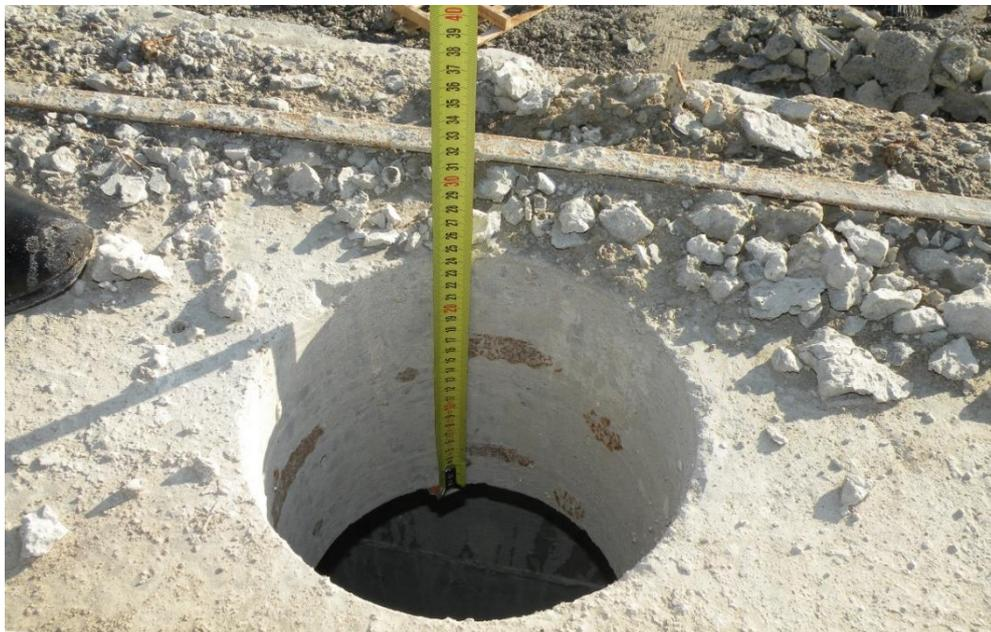
Фото 1. Прорез в плите покрытия. Смещение верхней арматурной сетки от проектного положения.
