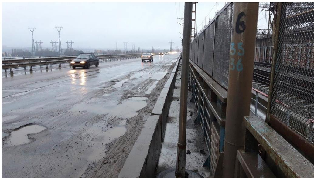
Рис.1 – Разрушения покрытия
