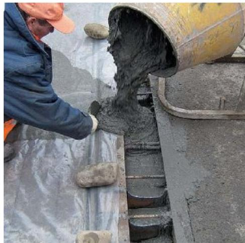
Рис. 2. - Emaco® Nanocrete AP - материал, полностью готовый к использованию, который представляет собой сухую бетонную смесь. В составе этой смеси содержится портландцемент, кварцевый песок, ретиспергированный порошок, а также специальные добавки.
