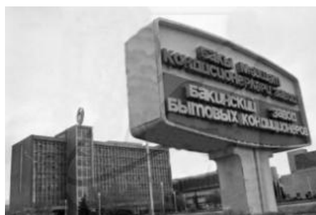
Рис.8 – Бакинский завод бытовых кондиционеров
