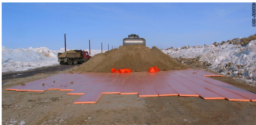
Рис. 3. Возведение насыпи дороги с экраном из пеноплекса в Новом Уренгое.
