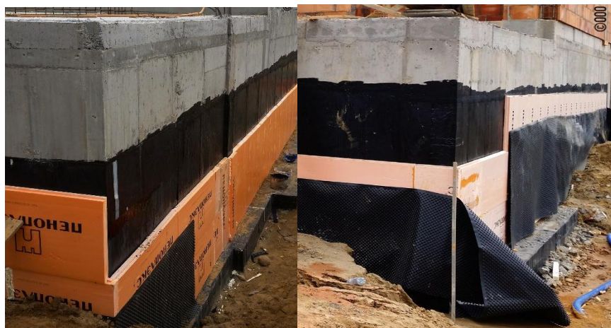
Рис. 4. Теплоизоляция фундаментов в условиях вечной мерзлоты.
