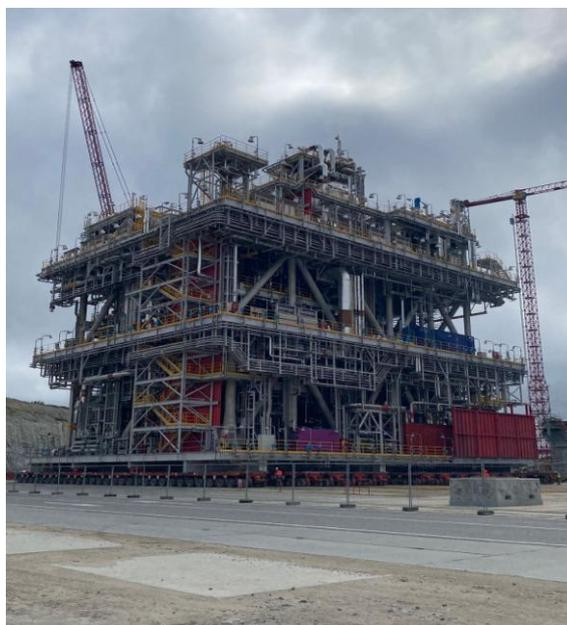
Рис. 1. Технологическая линия по сжижению природного газа на основании гравитационного типа
