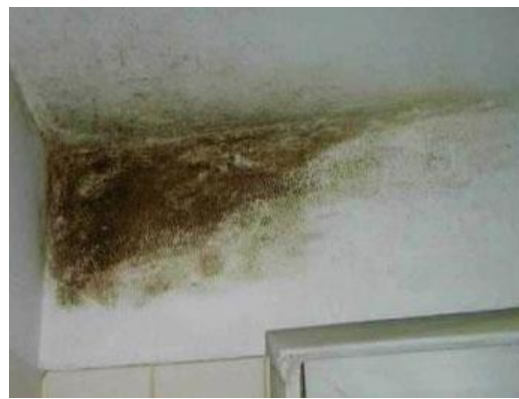
Плесень, обусловленная накоплением влаги в теплоизоляционном слое
