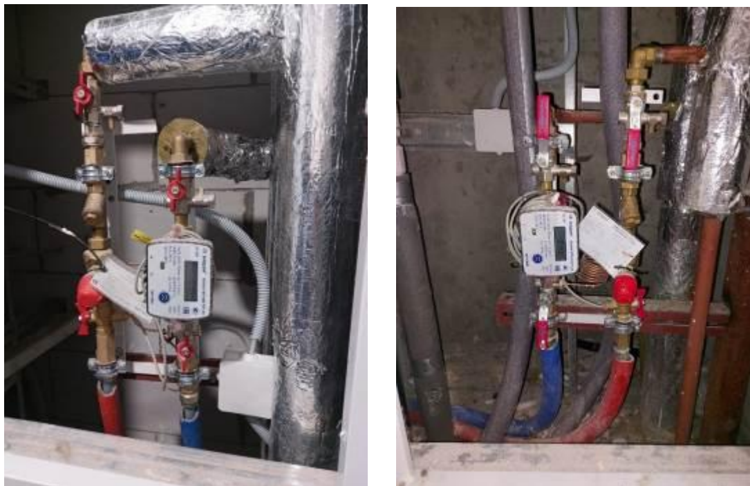
Рис. 1. – Пример установки квартирных станций
