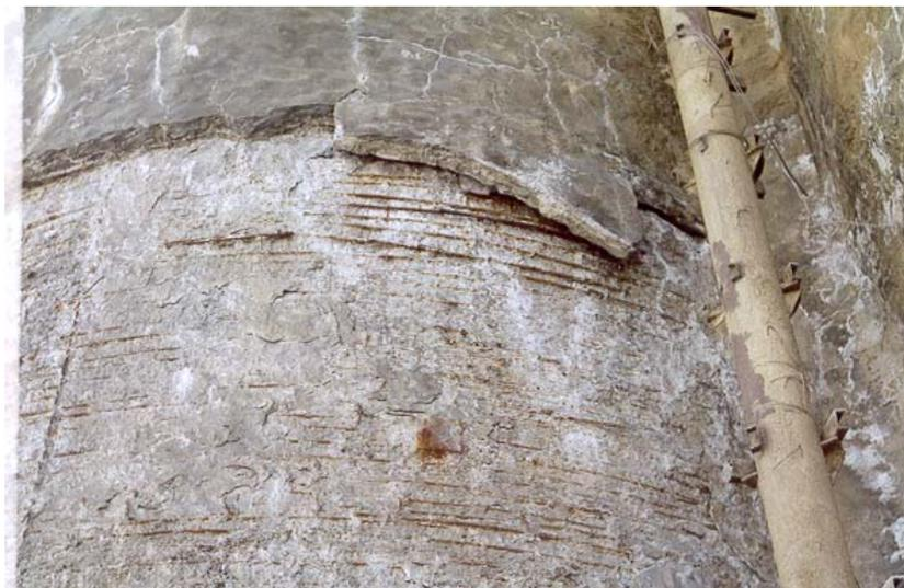
Рис.1. Отслоение внешнего железобетонного слоя оболочки
